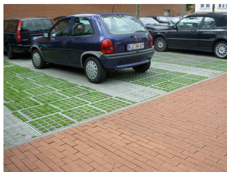
Doorlatende parkeerzone van gemoduleerde grastegels en klinkers met open voegen in Herford (Duitsland)
