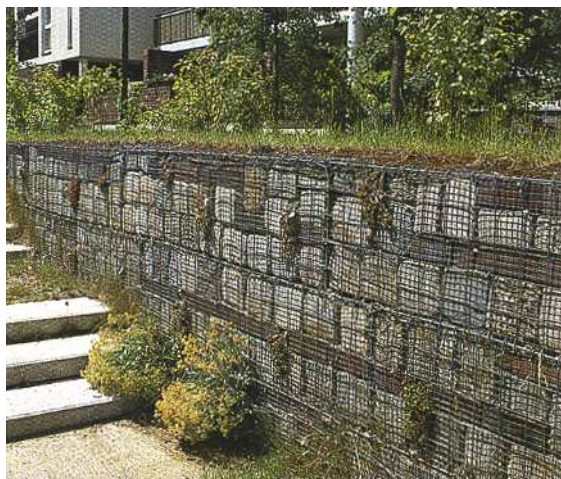
Muur opgebouwd met schanskorven
