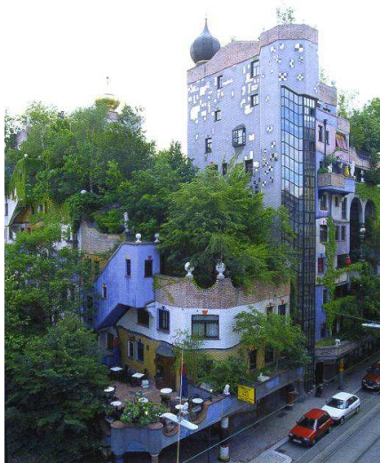
Het Hundertwasser-huis in Wenen - Bron: Dunnet, N; Kingsbury, N, Toits et murs végétaux
