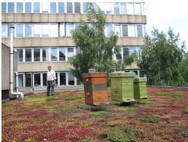
Extensief groendak en bijenkorven, kantoorgebouwen van het BIM, Sint-Lambrechts-Woluwe
