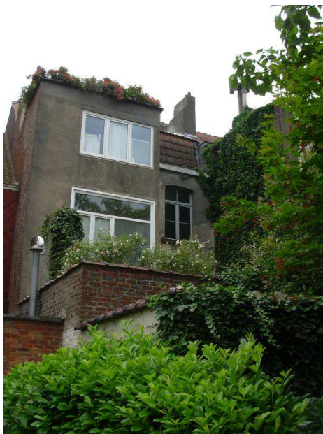
Groendaken en groene gevels aan de achterkant van een appartementsgebouw in Anderlecht
