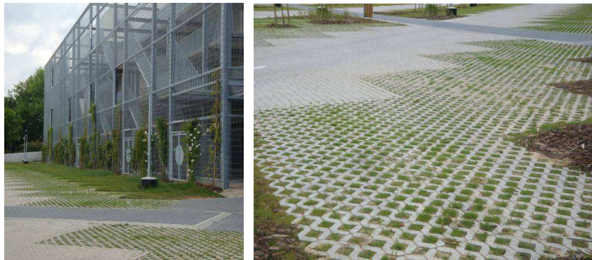
Doorlatende parkeerzone van grastegels in Sint-Lambrechts-Woluwe (Cameleon)
