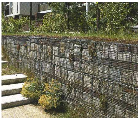
Mur constitué de gabions
