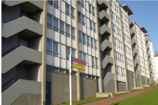
Voorbeeld van een open trappenhuis dat inspringt tegen opzichte van het gevelvlak.
