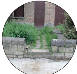
Moellons à réutiliser suite à la modification des entrées
