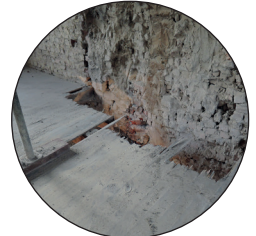
Fermeture des trémies de cheminées existantes avec plancher des nouvelles trémies
