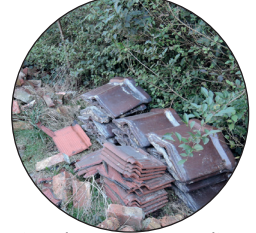
Couverture de mur en terre cuite vernissée remis dans le circuit
