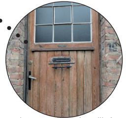
Portes existantes d'entrée utilisées comme portillon extérieur
