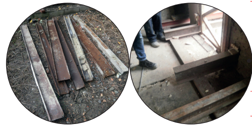
Les poutrelles métalliques déposées sont utilisées sur chantier pour étançonnement
