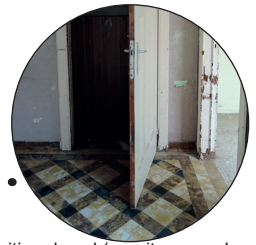
Finition de sol (granito - carrelage en ciment...)
