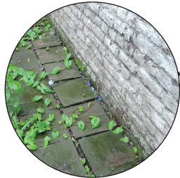
Dalles klinkers des terrasses arrières pour aménagement du chemin d'entrée
