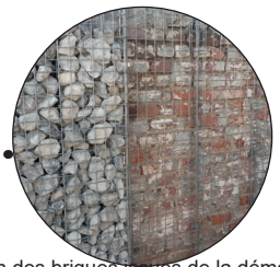
Utilisation des briques issues de la démolition pour soutenir des différences de niveau (mur en gabion)
