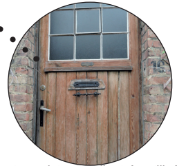
Portes existantes d'entrée utilisées comme portillon extérieur
