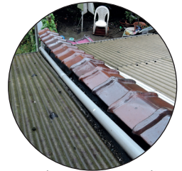
Couverture de mur en terre cuite vernissée remis dans le circuit
