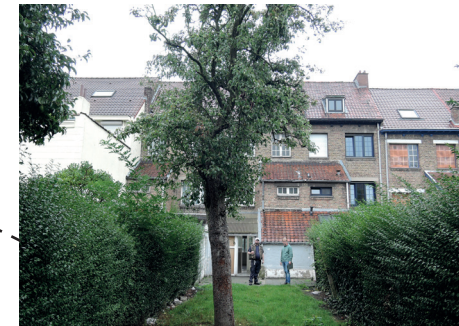
Façade arrière maison n°145
