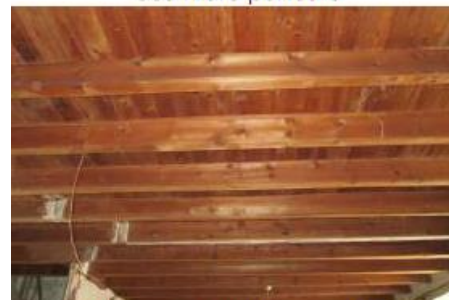
Gîtes des planchers existants
