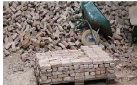
Briques réemployées pour reboucher des murs porteurs
