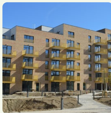
Waterranonkel in Haren: 66 sociale woningen voor de Brusselse Woning
