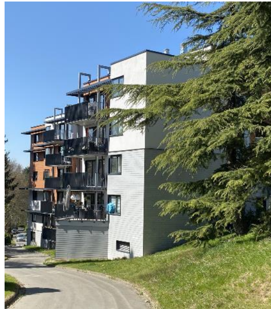
Van Nerom – Réno enveloppe
