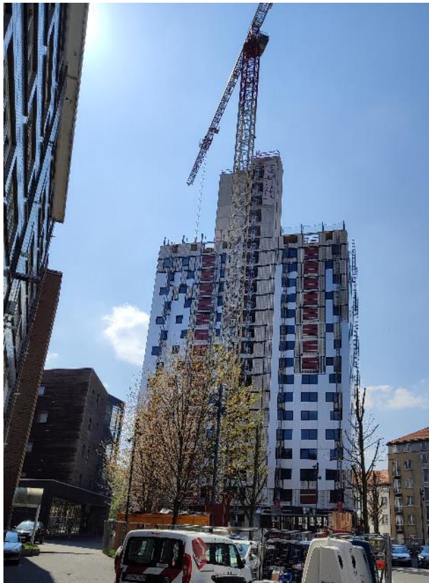
Tour Brunfaut – Rénovation complète
