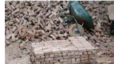
Briques réemployées pour reboucher des murs porteurs
