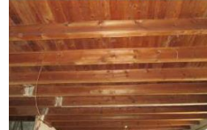
Gites des planchers existants
