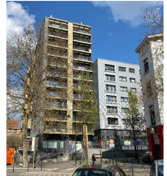
Bloemisten Lacaille – Renovatie gebouwschil
