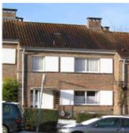
Maison 2F 114 m 2 3CH
