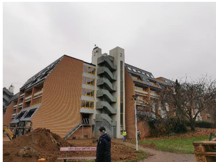
Vriendschapswijk - Renovatie gebouwschil Fase 1
