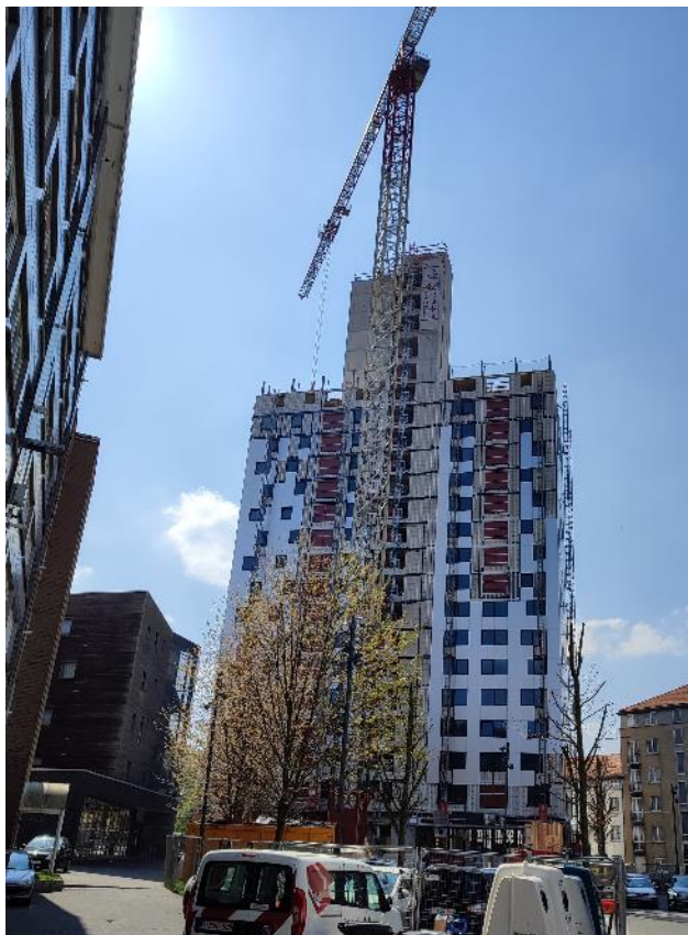
Brunfauttoren – Volledige renovatie
