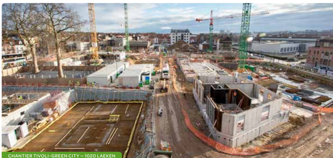
CHANTIER TIVOLI-GREEN CITY – 1020 LAEKEN
